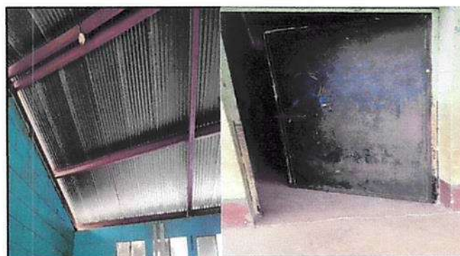
Foto 4: Mantenimiento a estructura metalica y a puertas
