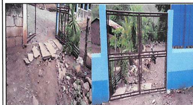
Foto 3: Torta de cemento en entrada principal y mantenimiento a porton
