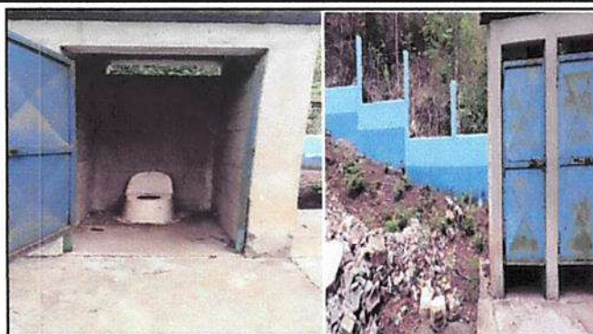
Foto 2: Mantenimiento de puertas de los baños y sustituciones de sanitarios
